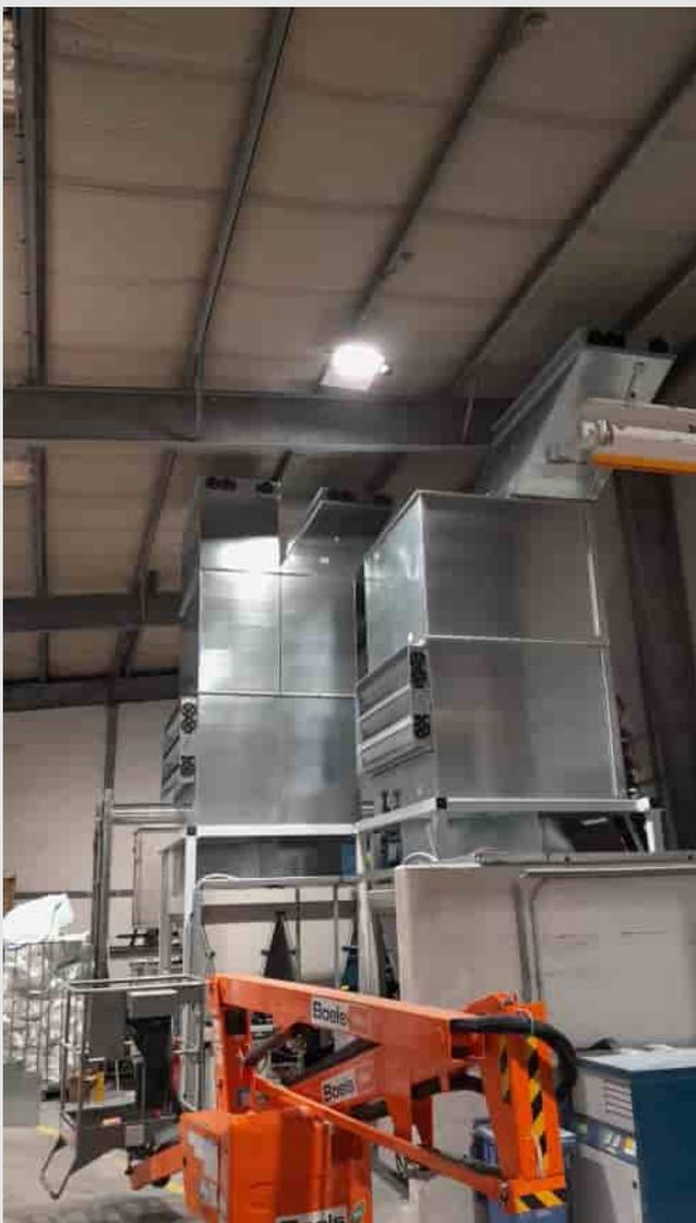
Über die neue Hauptleitung und die neu positionierten Regelventile werden die einzelnen Mischer mit Kaltwasser versorgt. Der Rückfluss wird in einem Pufferspeicher geführt, wo er über zwei Kaltwassersätze (Chiller mit je 200 kW) mit insgesamt vier Kältekreisläufen abgekühlt wird.
