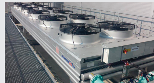
Dachaufstellung Rückkühler
