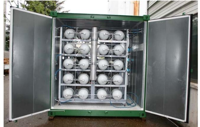
Isolierter Stahlcontainer mit Stahlblechboden, Durchbrüchen, sowie Zugangstür, ausgestattet wie folgt:
