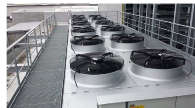
Installation Rückkühleranlage 600 kW 3105 Unterradlberg
