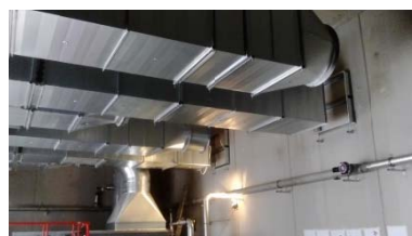
Lüftungsinstallation für 2 x Kompressoren á 300 kW 5282 Ranshofen
