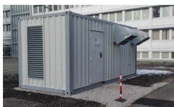
Container am endgültigen Aufstellort in 3100 St. Pölten
