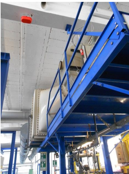
Wärmetauscher, Lüftungsverrohrung
